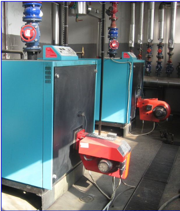
Слика бр.VI-1: Два котли во котларата на инсталацијата
