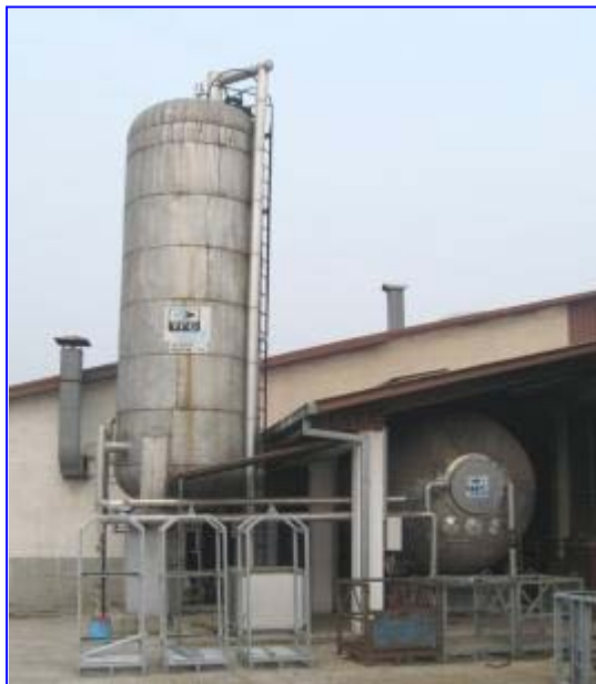
Слика бр.V-3: Резервоари за CO 2
