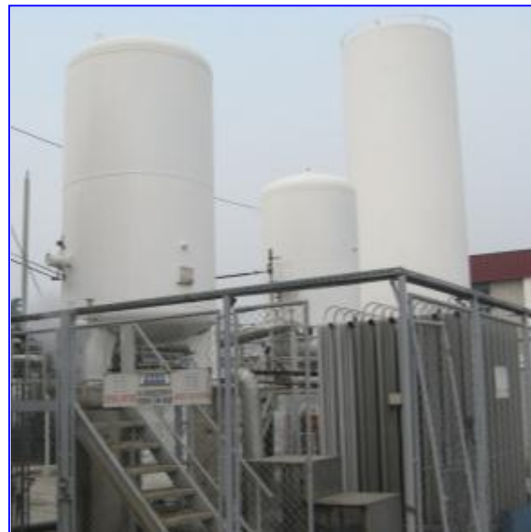
Слика бр.V-4: Резервоари за Ar и N 2
