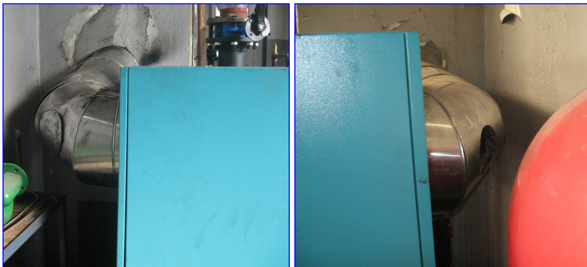
Слики бр. IX-2 и бр. IX-3: Мерни места на емисииво воздухот од двата котли K1 и K2 приклучени на заеднички испуст A1
